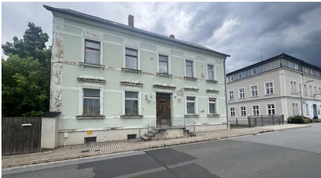
Abbildung 23: Eine sanierungsbedürftige Immobilie im Ortskern von Königswartha
