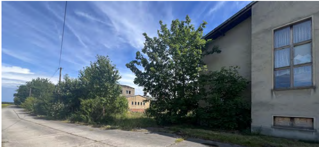
Abbildung 38: Blick auf die ehemalige Schweinemastanlage südlich des Planareals
